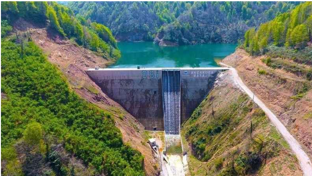
Fig. 1. Akçakoca Dam (DSİ 2023).
