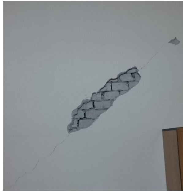
b) Block B- Silicate masonry
